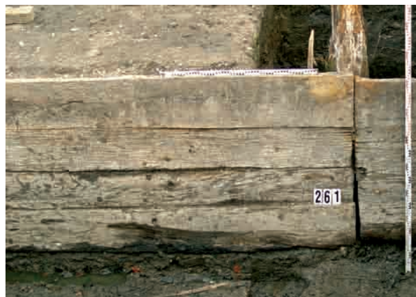
Il. 111. Fragment nabrzeża z XVII wieku wykonany z rozebranych jednostek rzecznych, odkryty przy ul. Wartkiej w Gdańsku (fot. K. Dyrda)
